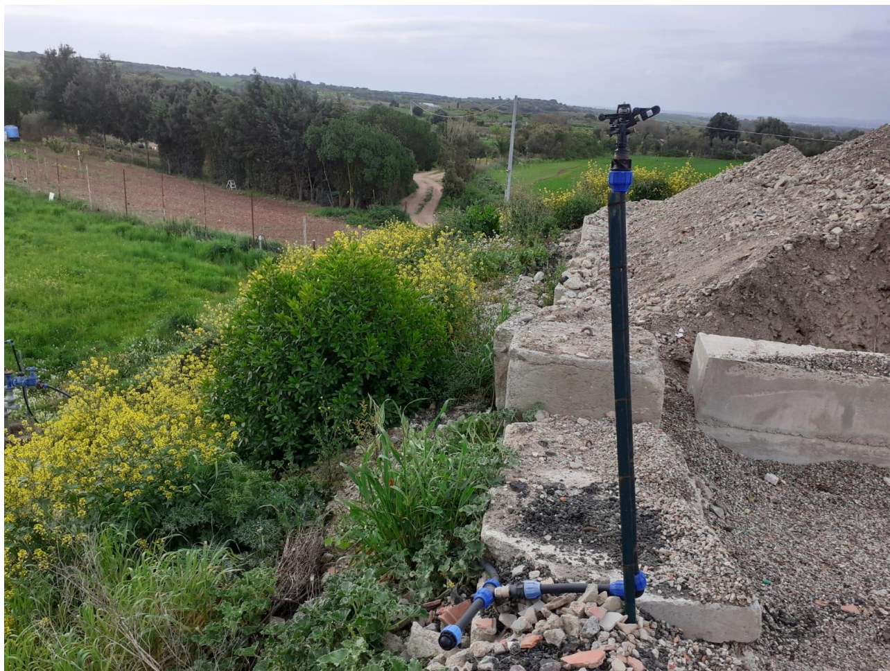
Fig. 11 Sistema di irrogazione dell'acqua per inumidimento dei cumuli
